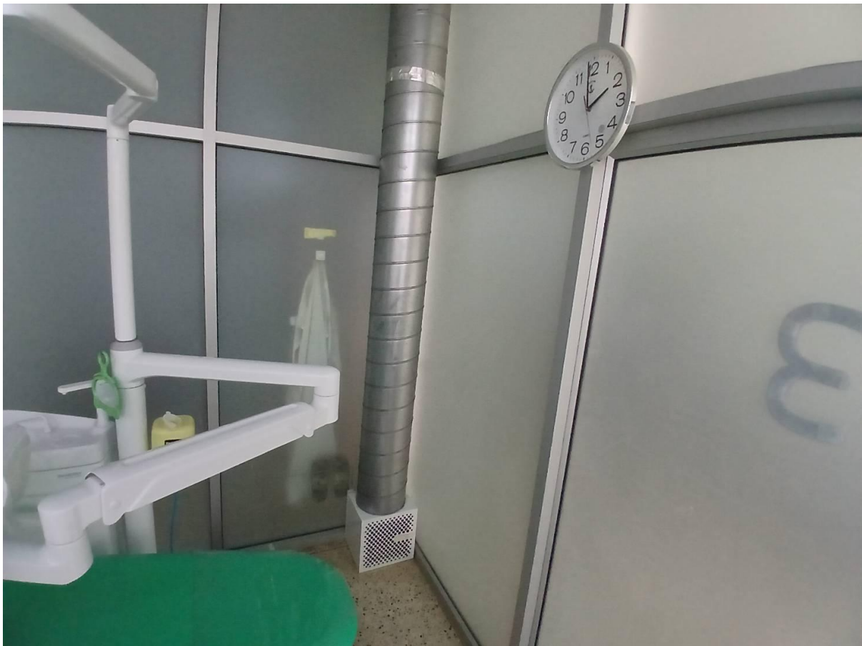
ห้องควบคุมการติดเชื้อ แผนกทันตกรรม
