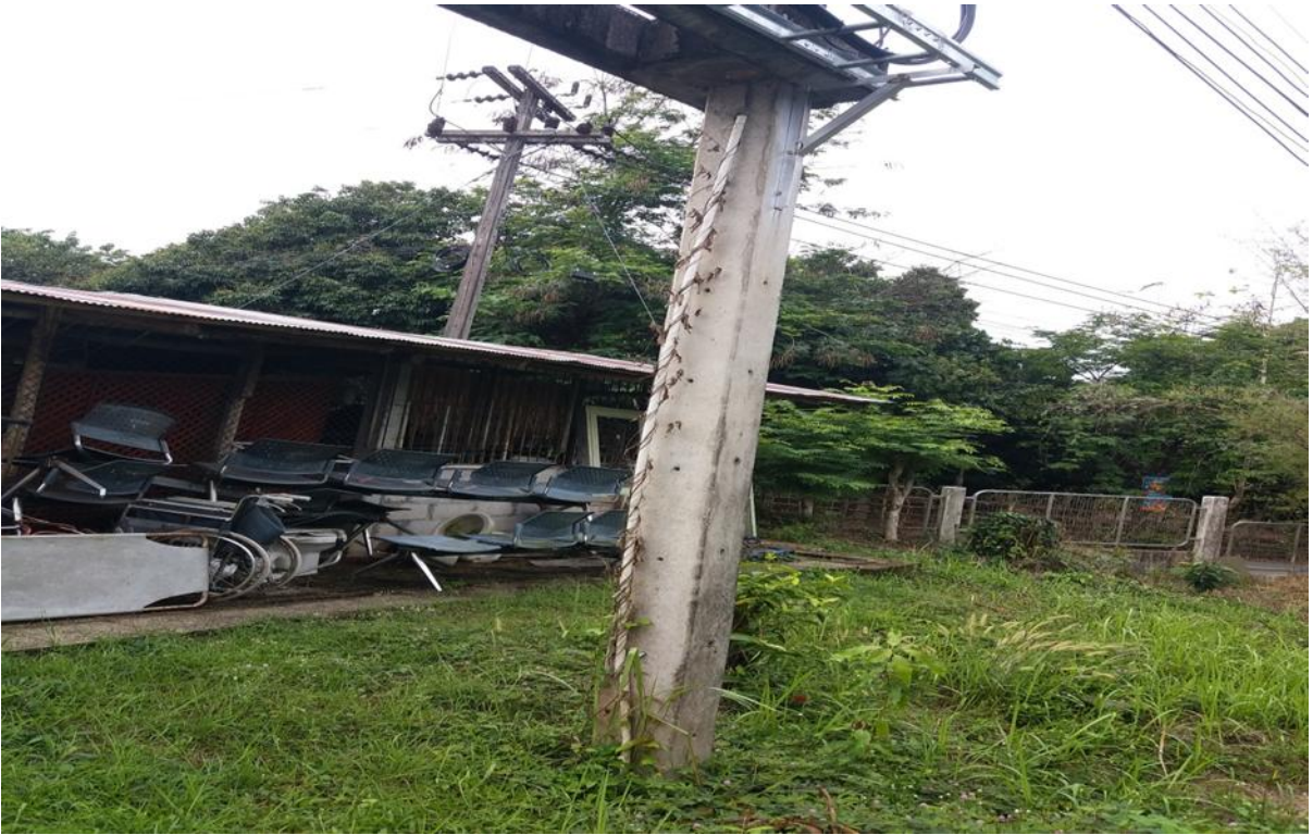
จุดต่อลงดินของเครื่องกำเนิดไฟฟ้าสำรองฉุกเฉิน
