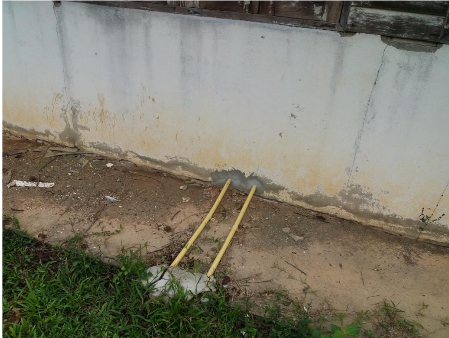
ระบบต่อลงดินของแผงเมนประธานหลักประจำอาคาร (ตู้ MDB)
